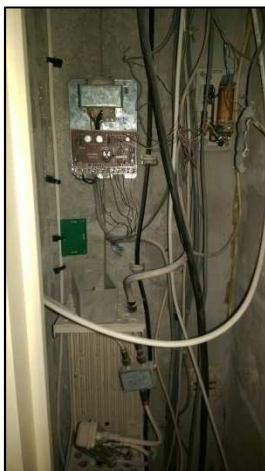
Figure 40 : Colonne télécom et télévision en gaine palière
