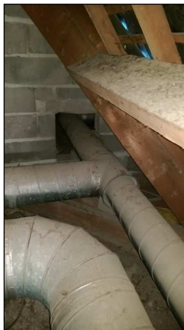
Figure 29 : Cheminement des gaines d'extraction en combles
