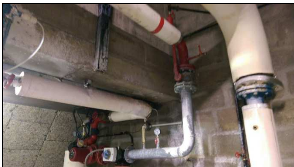
Figure 13 : Calorifuge manquant en Sous-Station
