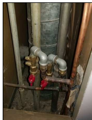
Figure 24 : Vanne de la colonne de distribution de l'eau chaude sanitaire
