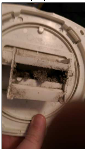
Figure 32 : Bouche d'extraction encrassée
