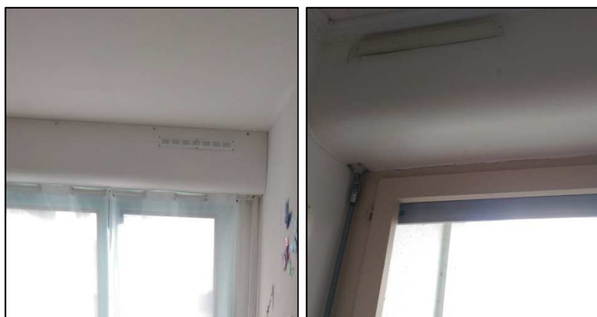
Figure 7 : Infiltrations d'air présentes au niveau du coffre des volets roulants
