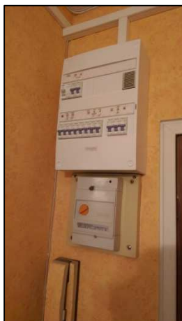
Figure 38 : Exemple de tableau électrique en logement remplacé
