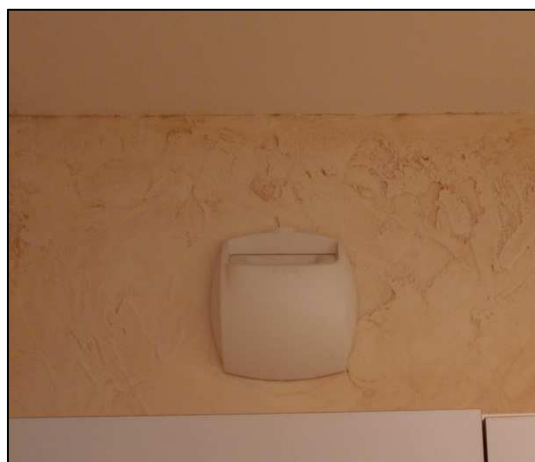
Figure 30 : Bouche d'extraction en salle de bains
