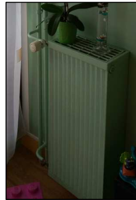
Figure 18 : Radiateurs avec robinet thermostatique
