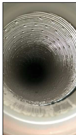
Figure 33 : Conduit entre colonne et bouche d'extraction
