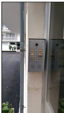
Figure 41 : Positionnement de la platine de rue et du combiné d'interphonie en logement
