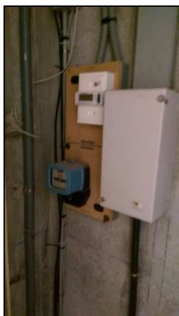
Figure 39 : Compteur électrique en gaine palière
