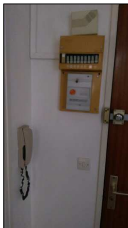
Figure 41 : Positionnement de la platine de rue et du combiné d'interphonie en logement
