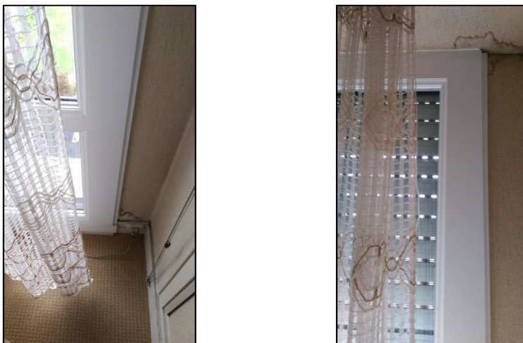
Figure 6 : Infiltrations d'eau présentes avant le remplacement des menuiseries
