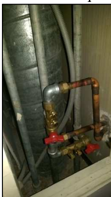
Figure 23 : Vanne de la colonne de distribution de l'eau chaude sanitaire en fin de réseau
