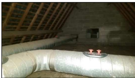
Figure 27 : Cheminement des gaines d'extraction en combles
