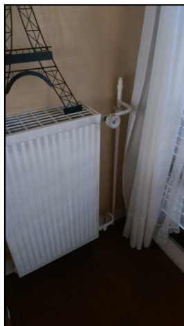
Figure 21 : Purgeur d'air au point le plus haut de la colonne de chauffage
