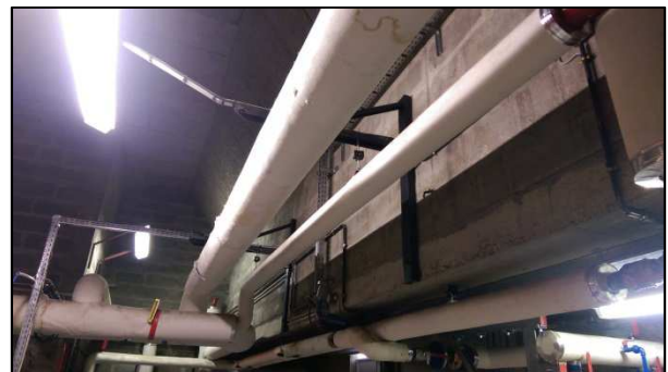
Figure 15 : Calorifuge abîmé en Sous-Station
