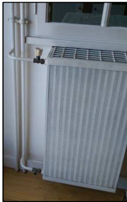
Figure 17 : Radiateurs avec robinet simple réglage
