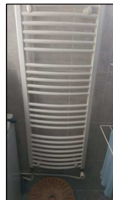
Figure 20 : Sèche-serviettes en salle de bains avec robinet simple réglage
