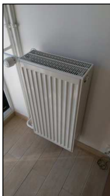
Figure 19 : Radiateur remplacé avec robinet thermostatique
