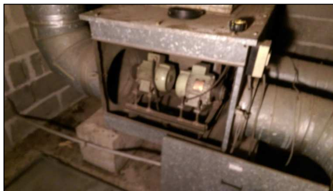
Figure 25 : Caisson d'extraction en combles
