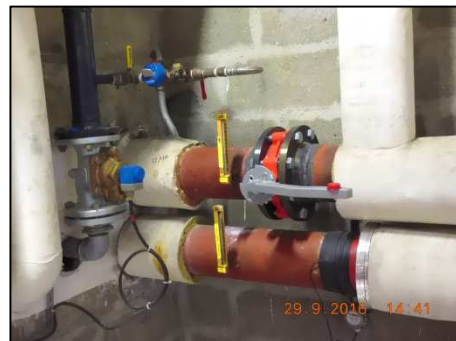
Figure 16 : Calorifuge manquant suite au remplacement d'une vanne
