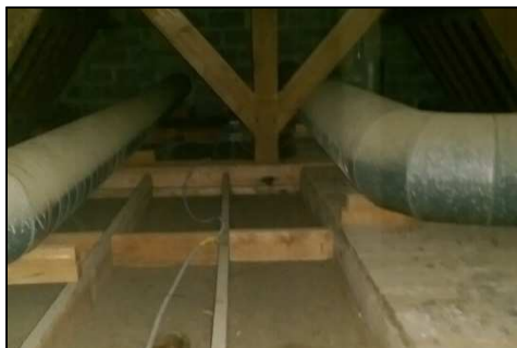
Figure 28 : Cheminement des gaines d'extraction en combles
